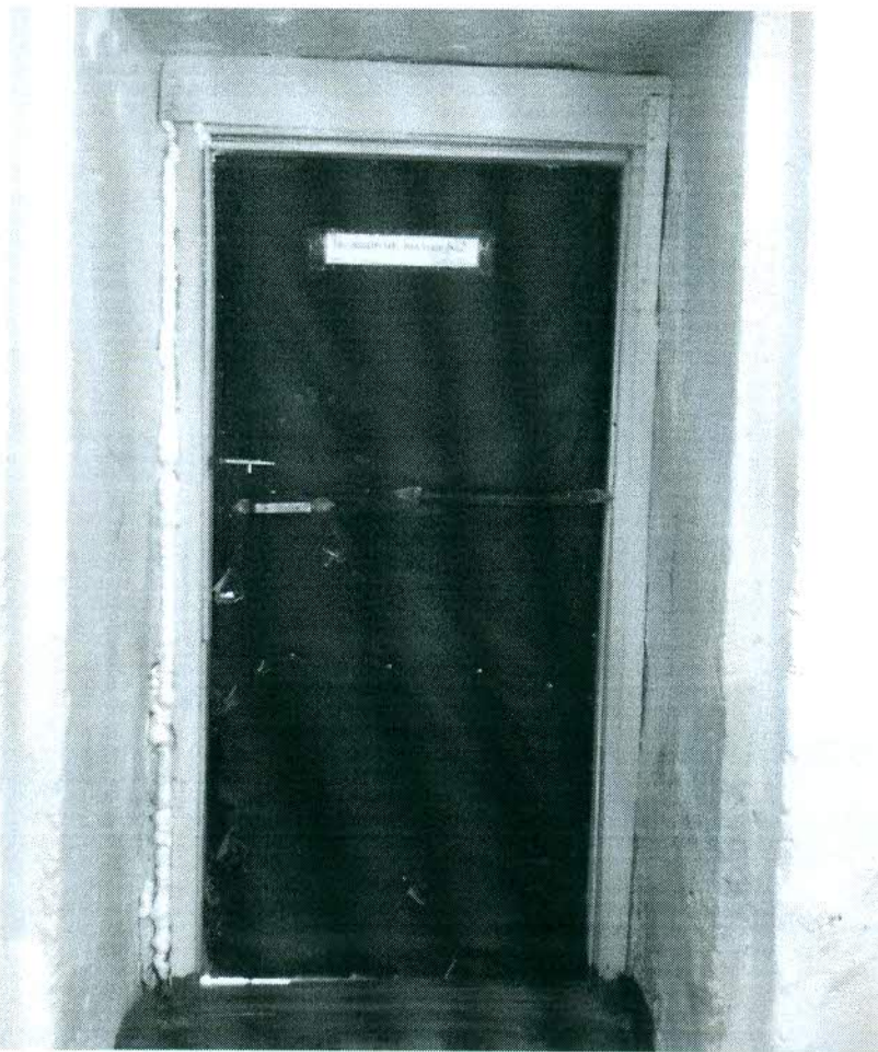
Рис. 42. Эвакуационный выход, дверь – 0,80 м.
