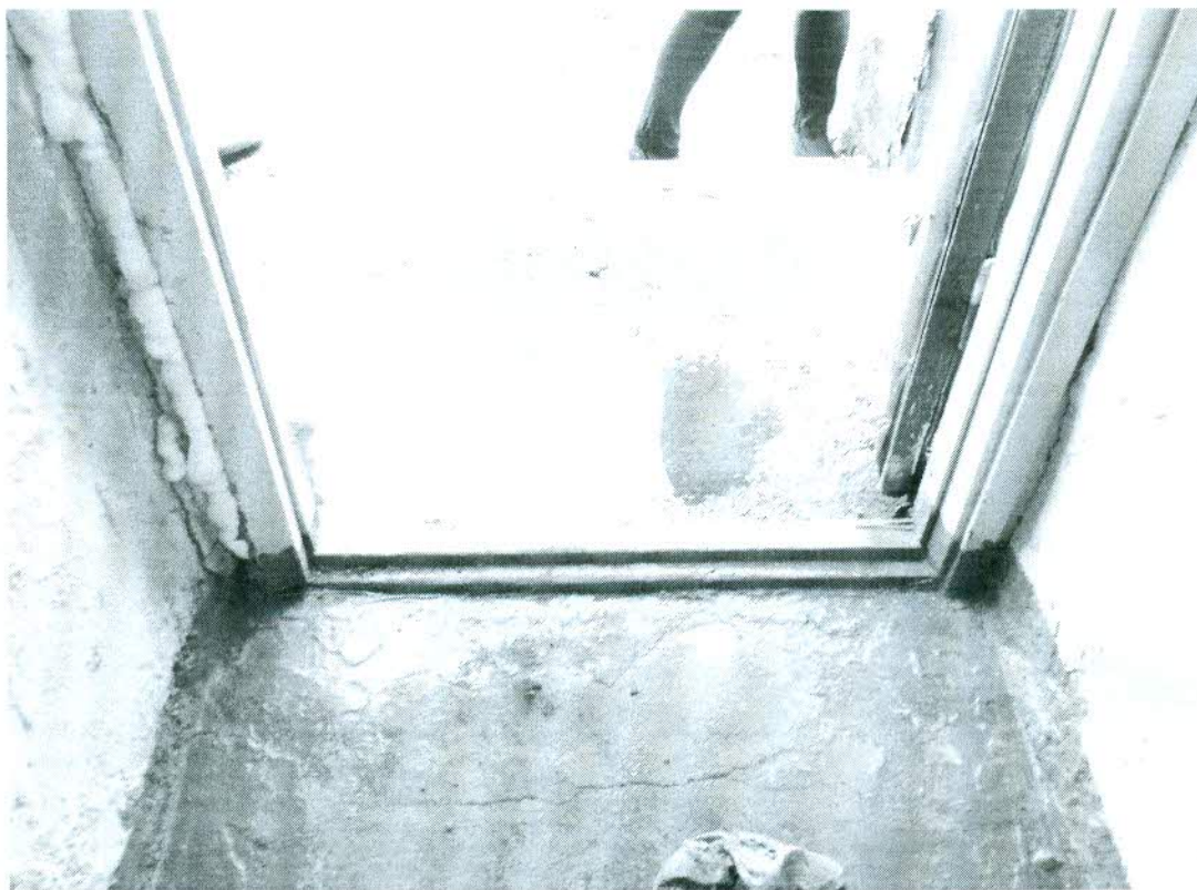
Рис. 44. Эвакуационный выход, порог – 0,05 м.
