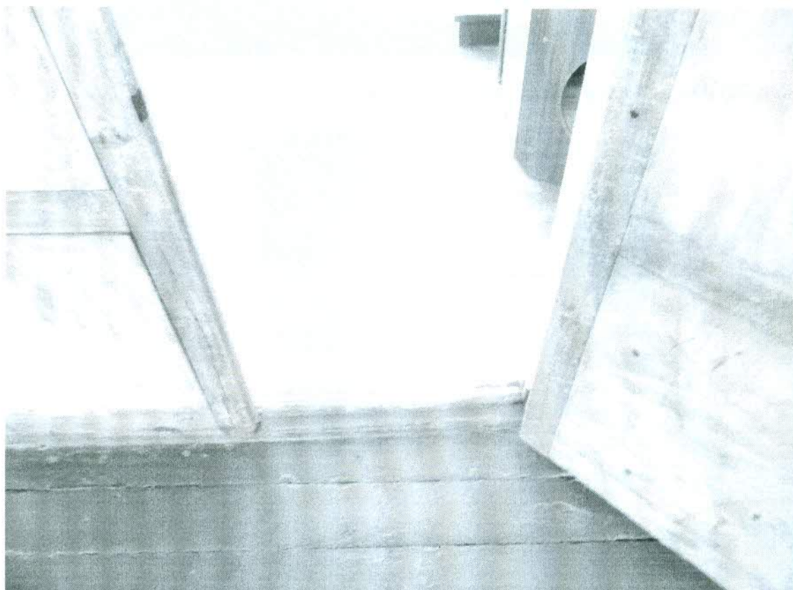
Рис. 21. Вход в кабинет, порог – 0,03 м.
