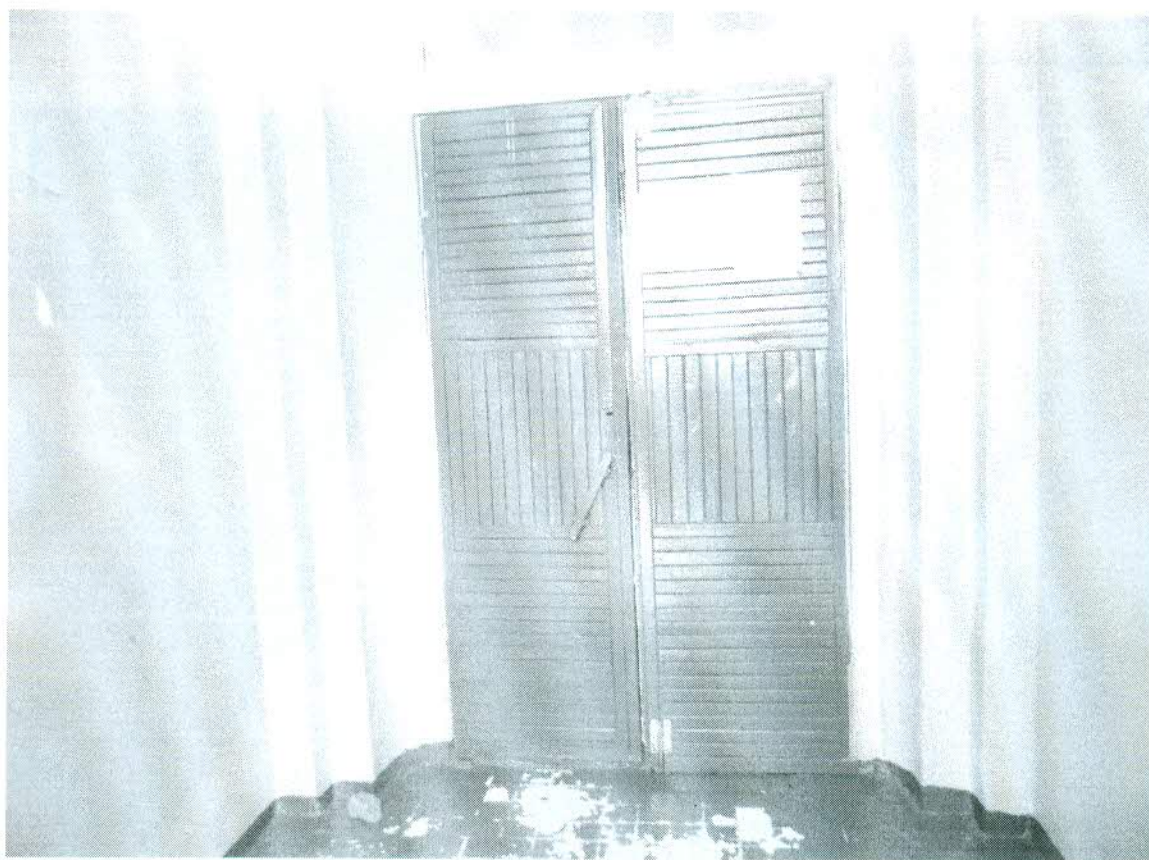
Рис.8. Входная дверь в вестибюль – 0,7+0,7 м.
